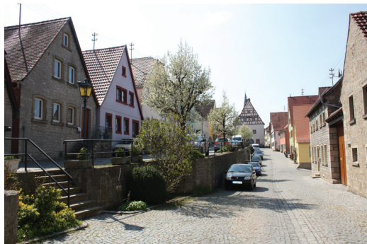
Die Harbachstraße ist aufgrund der Hanglage in zwei Ebenen durch eine mittlere Stützmauer geteilt. Die geschlossene giebelständige Bebauung bildet die historisch gewachsene Raumkante.
