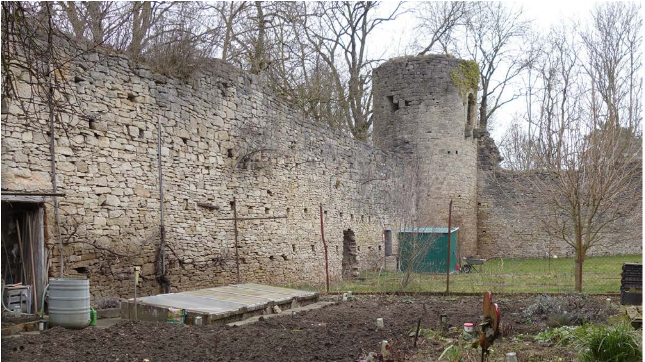
Schäden an den Mauerkronen im Nordosten der Stadtbefestigung
