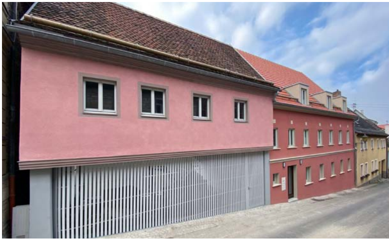
Sanierte historische Fassade mit integrierter Garagennutzung
