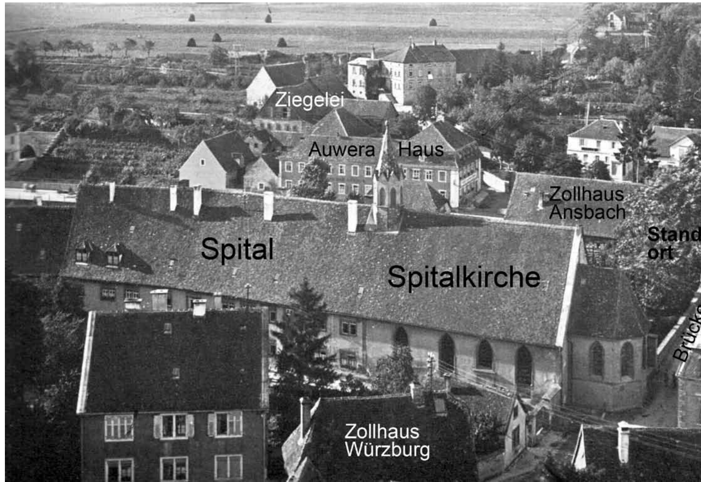
Überblick zur Lage der Gebäude an der Gollachbrücke
