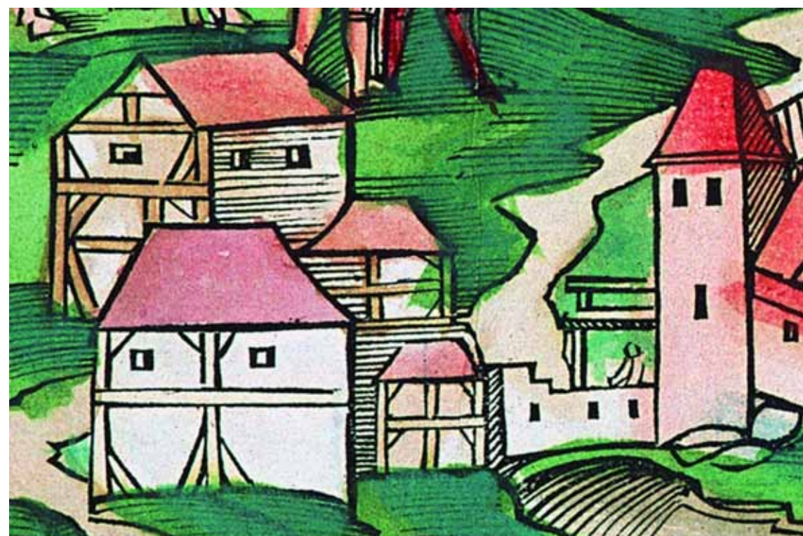
Auf der ältesten Stadtansicht von Aub von 1523 ist die Konstruktion einer hölzernen Zugbrücke am unteren Torturm erkennbar. Bis zum Ende des 18. Jahrhunderts ist ihr Bestehen nachweisbar.
